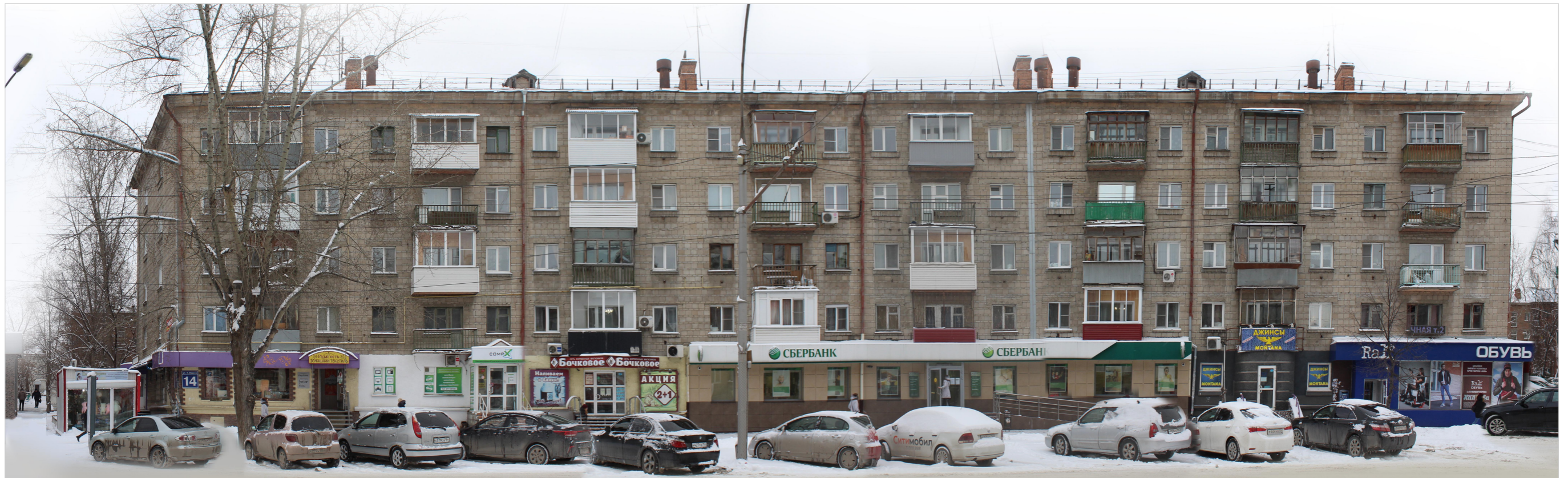
Главный фасад 1-13, выходящий на проспект Карла Маркса
